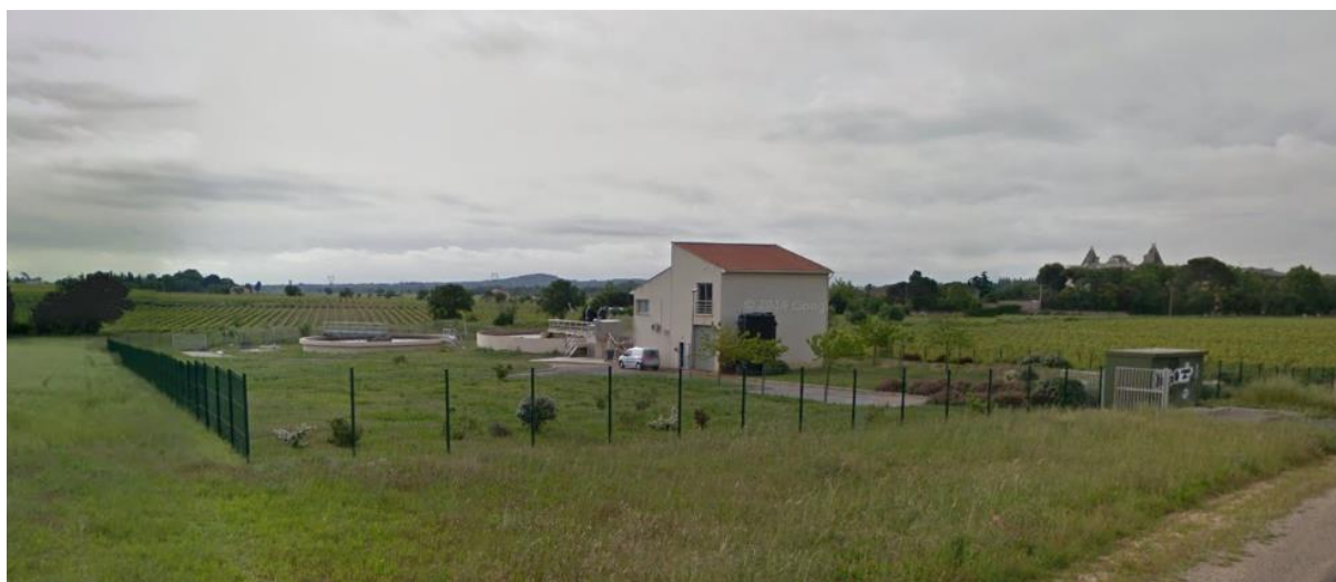
Station d'épuration du S.I.V.U Montblanc – Valros
