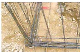
Nœud de chaînage - Continuité mécanique
