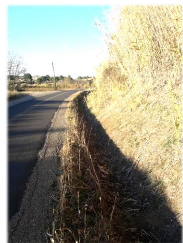
Curage des fossés
